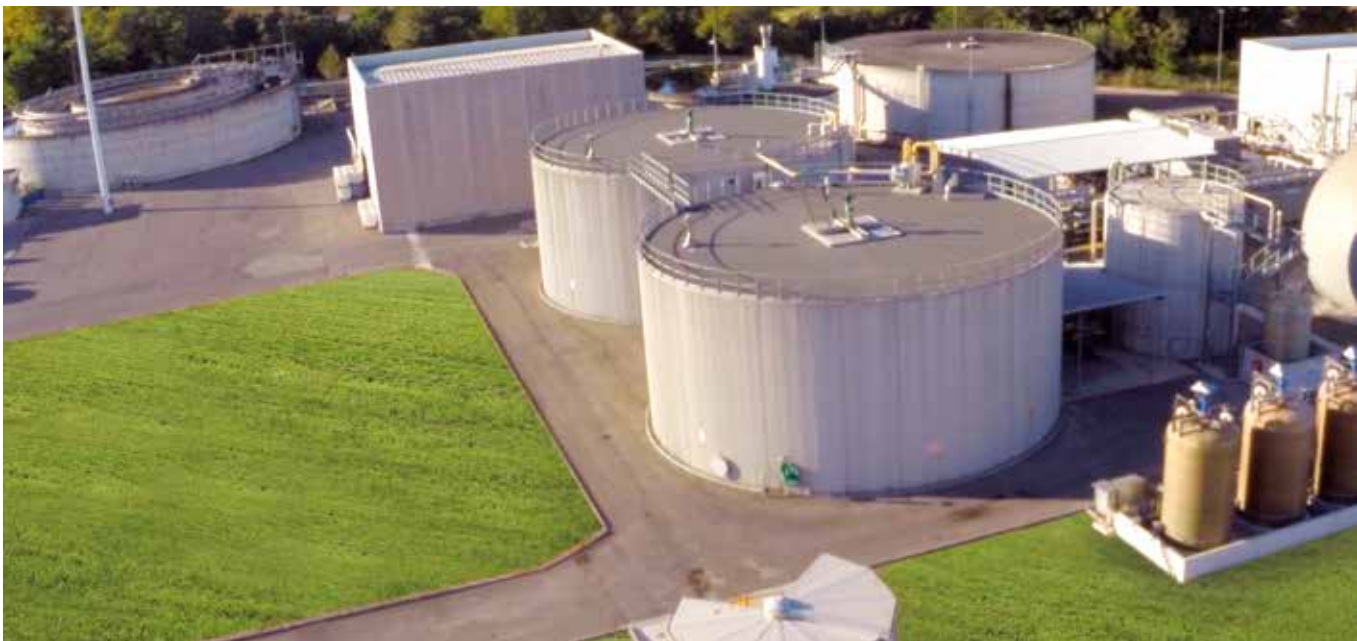
Impianto di Biogas, Ospedaletto Lodigiano (LO)
