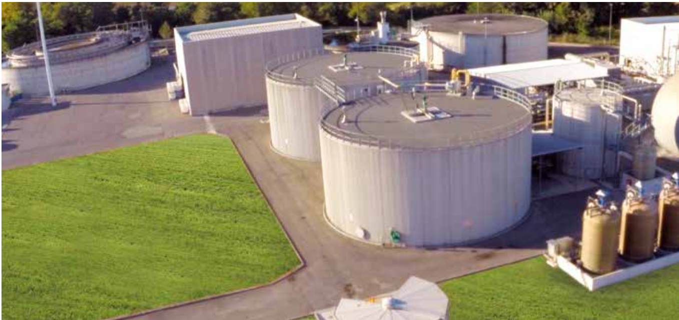
Impianto di Biogas, Ospedaletto Lodigiano (LO)
